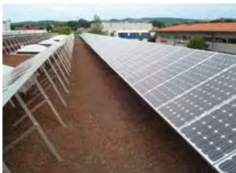
Auch hier wurden Gründach und PV-Anlage kombiniert: Die Aufstellschienen versinken in der extensiven Begrünung und benötigen dank ihres Eigengewichts keine Fixierung
