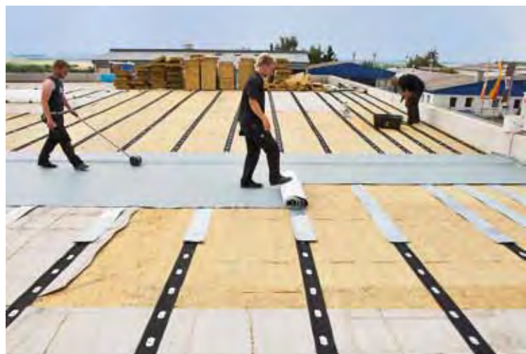
Ausrollen der Dachabdichtung über die fixierten Klettbänder
