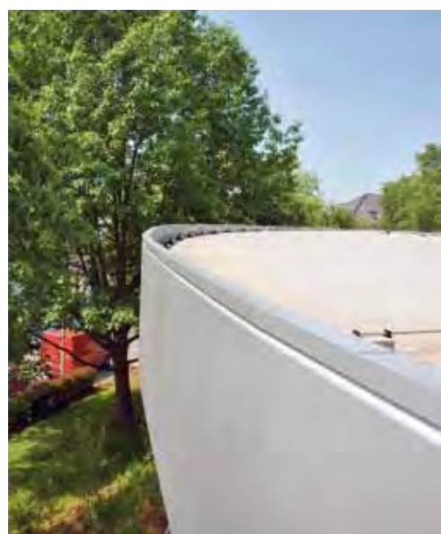
Mehrteilige Dachrandprofile ermöglichen eine schadensfreie thermische Dehnung
