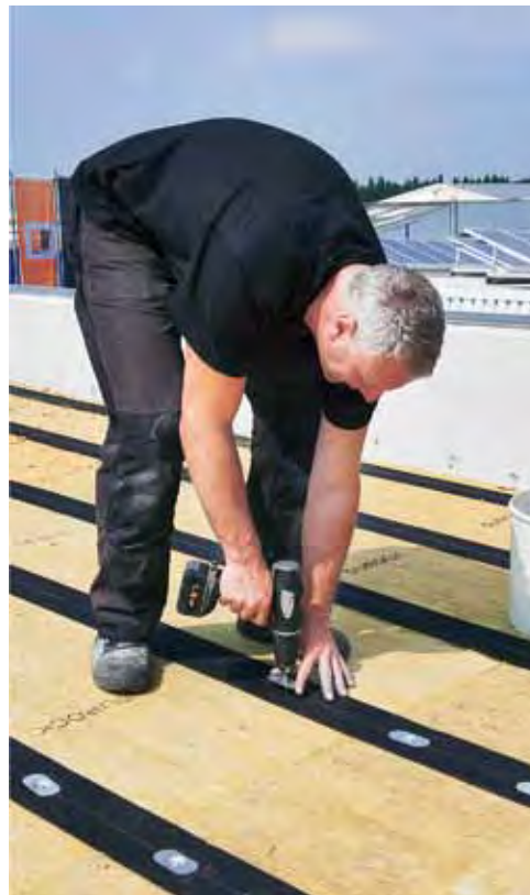
Vorbereitung für die Fixierung der Dachabdichtung im Klettsystem
