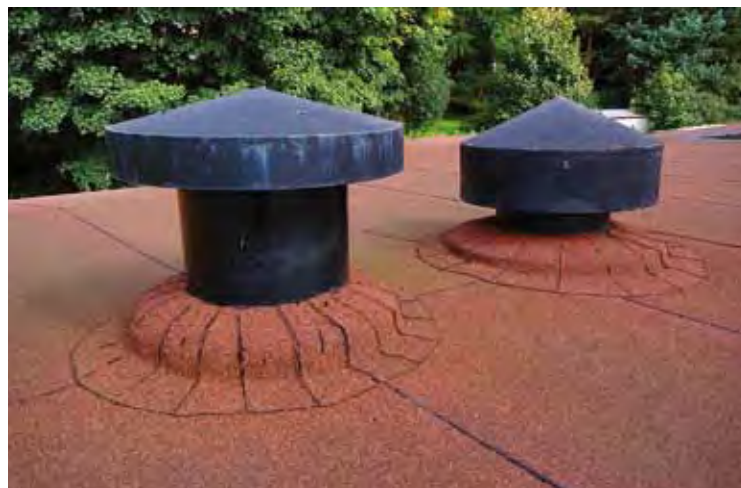
Beispiele für typische Durchdringungen auf dem Flachdach – in diesem Fall Rohrdurchführungen für die Entlüftung
