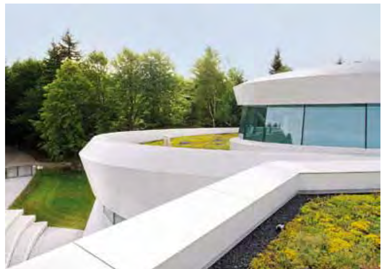
Die Rauigkeit der Oberfläche verringert die Windgeschwindigkeiten und durch die Durchwurzelung wird der Gründachaufbau großflächig festgelegt
