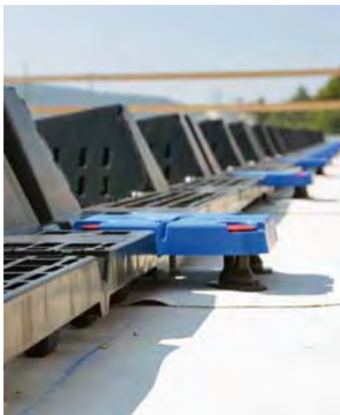
Dass es auch ohne Durchdringung geht, zeigt diese durchdringungsfreie Montage des Photovoltaiksystems Solfixx
