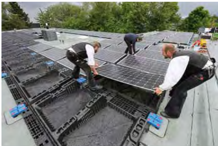
Die Solarpaneele werden aufgebracht, nachdem die Halterung sicher auf der Dachkonstruktion befestigt wurde
