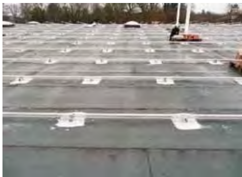
Spätere Schäden nicht ausgeschlossen: Die Abdichtung der Befestigungspunkte wurde hier nicht fachgerecht ausgeführt
