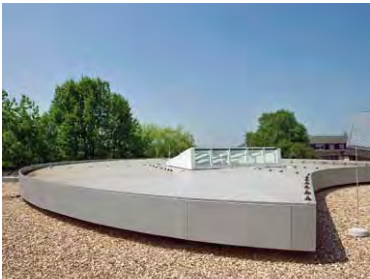
Die markante Formgebung der Dachrandausbildung ergibt eine neue Dachform auf dem Dach
