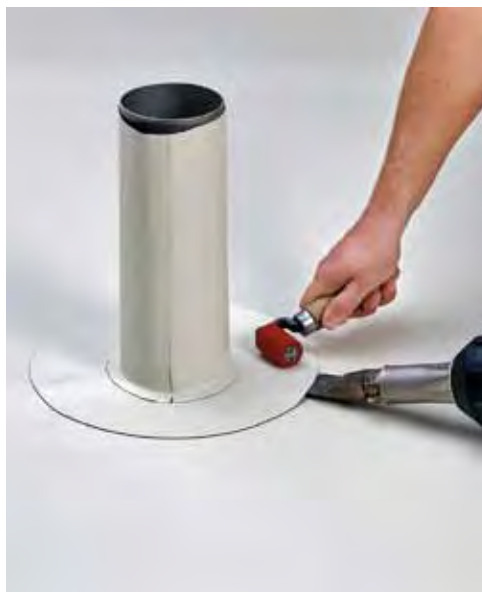
So wird fachgerecht eine Rohrdurchführung, in diesem Fall mit einer Kunststoffbahn, eingedichtet
