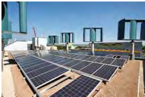
Beispiel für ganzheitliche Planung: Das Energiekonzept für das Gebäude ist so ausgelegt, dass mittels Windkraft, Photovoltaik und Geothermie mehr Energie erzeugt als verbraucht wird
